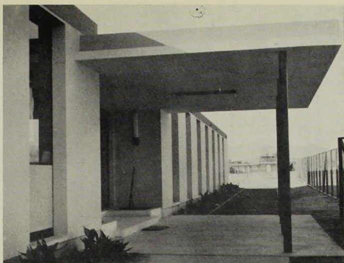
Vista del ingreso.
